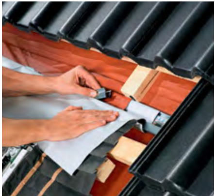
Montaż rynienki do odprowadzenia wody
